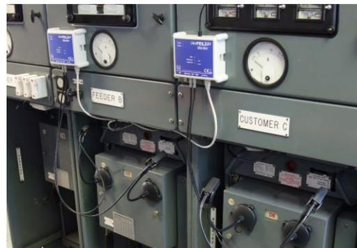
Monitorización en tiempo completo se puede utilizar para eliminar la limitación principal de otros métodos, la incapacidad para detectar intermitentemente. Con cualquier prueba periódica, el PD debe estar presente en el día en que el equipo se prueba. Si no, el problema no puede ser encontrado. Se ha comprobado que serios problemas de daño en el aislamiento causados por PD, pueden existir y bajo las condiciones ambientales correctas, las DP no estarán presentes.
