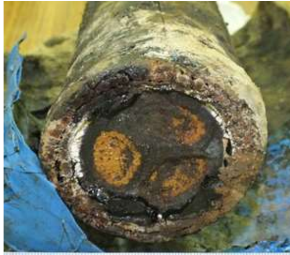
Figura 14: Cable PILC averiado
