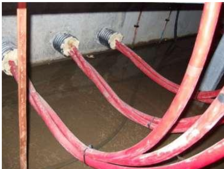
Abbildung 3 - Überschwemmte Kabelrinne
