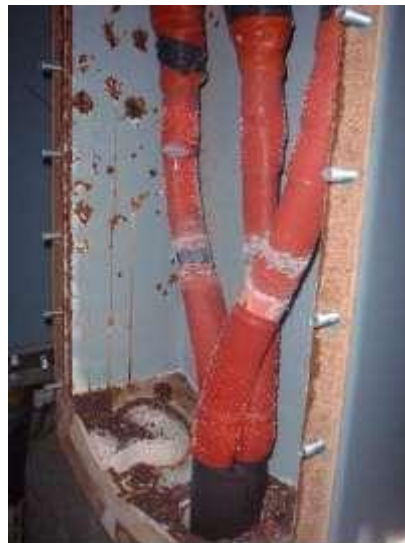
Abbildung 5 - Entladung an einem Leistungsschalter, verursacht durch hohe Feuchtigkeit und einen Designfehler
