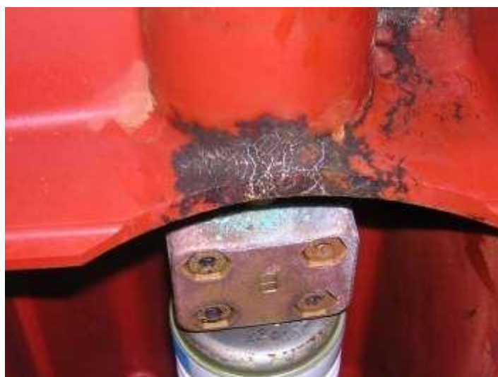
Abbildung 5 - Entladung an einem Leistungsschalter, verursacht durch hohe Feuchtigkeit und einen Designfehler
