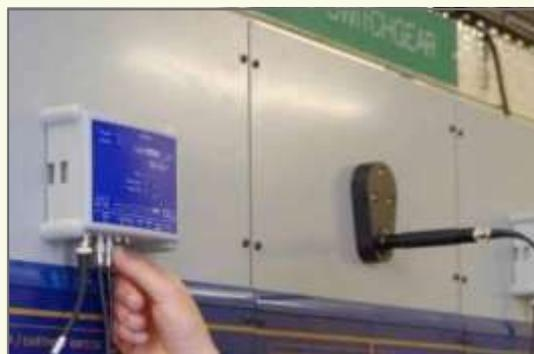
Los sistemas de monitoreo permanentes con capacidades web pueden recopilar, registrar y analizar información sobre el estado de varios equipos simultáneamente, y actuar como alarmas de fallas.
